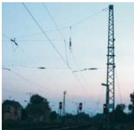
Figura 1: Configuración clásica de una catenaria
